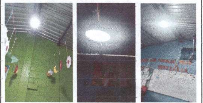
Foto 4: sustitución de lamparas led en cocina, aulas y dirección
