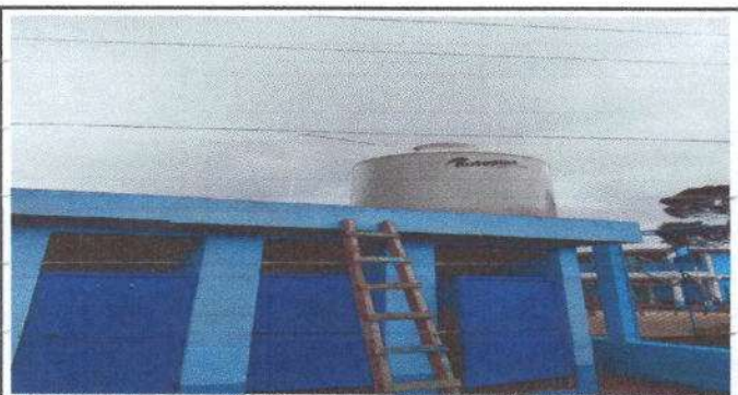
Foto 5: sustitucion de deposito de agua.
