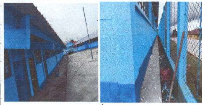
Foto 3: sustitución de pintura en paredes de aulas módulos 2 y 3
